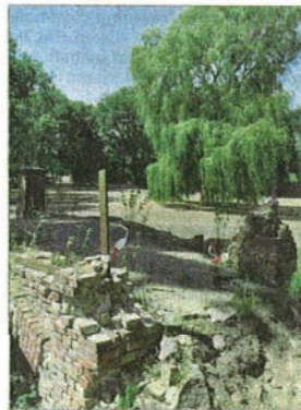
Die Brücke im Park soll nach historischen Fotos so original wie möglich wieder aufgebaut werden.
