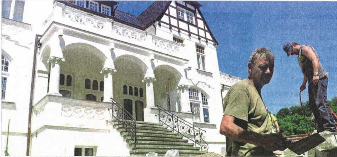
Arbeiter setzen vor der sanierten Villa ein Fundament für ein Jugendstilornament, das den Rand des befahrbaren Rondells schmücken wird.
